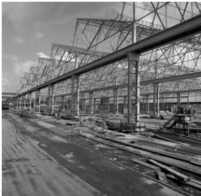
Bouw van een nieuwe hal voor de werkplaats van Cuesmes in 1965 (Ref. Z09944B)
