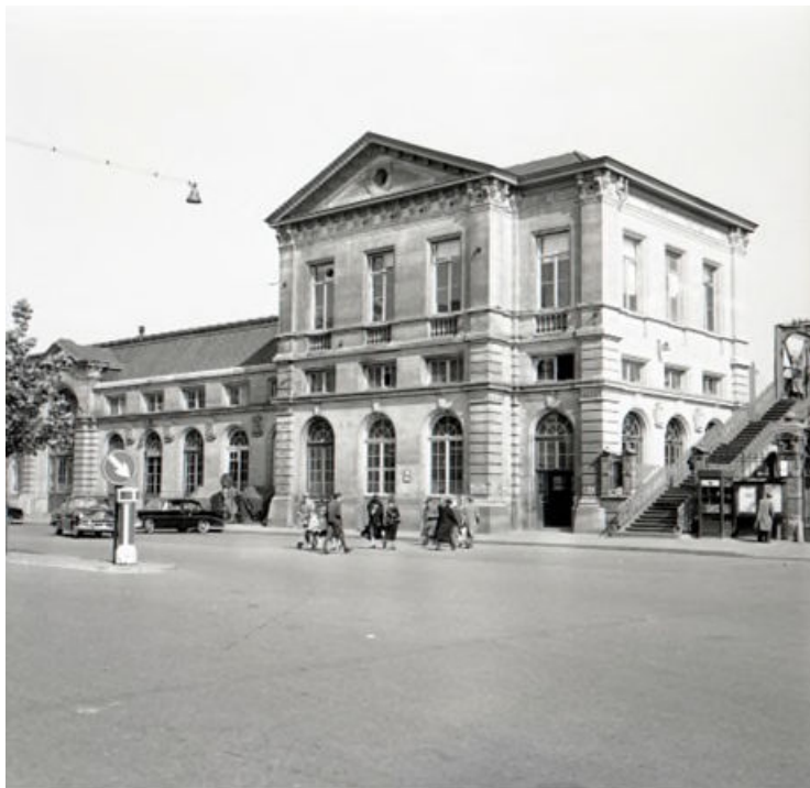
Bâtiment d'angle construit ultérieurement, 28 juin 1957 (Réf. Z02908A)
