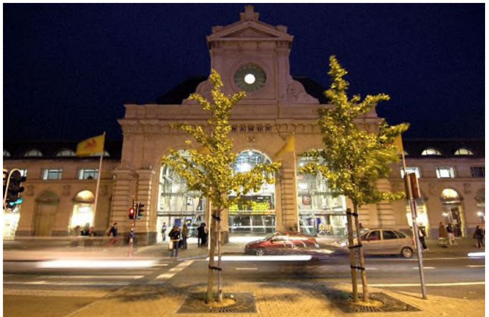
Façade avant de la gare après sa rénovation, octobre 2006 (Réf. D2855-05)
